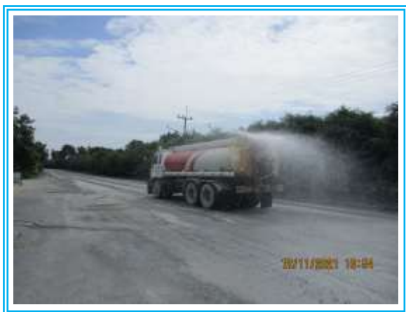
รูปที่ 3-25 ฉีดพรมน้ำเส้นทางขนส่งแร่ทางหลวงชนบท
